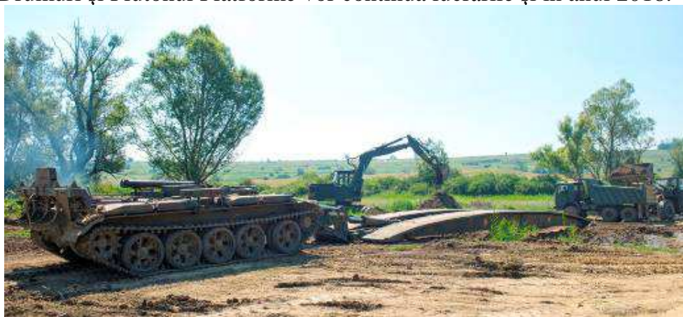
Foto. Excavatorul, încărcătorul frontal și autobasculanta utilizate la executarea infrastructurii drumului
