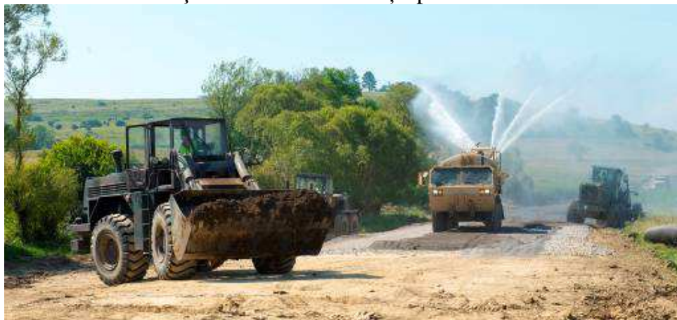
Foto. Încărcătorul frontal WOLLA utilizat la transportul pământului
