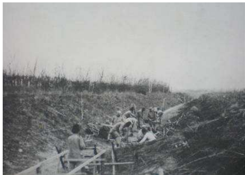
Geniști vâlceni construind un șanț de apărare pe frontul din Moldova
