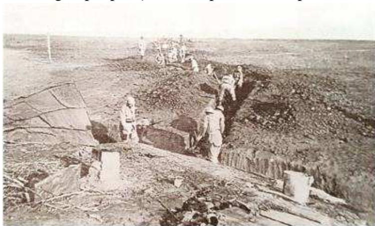
Cp. Pi.Rz. executând șanțuri de comunicații în adâncimea frontului, 1917
